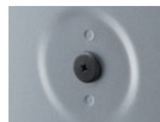
デッキサイド部
